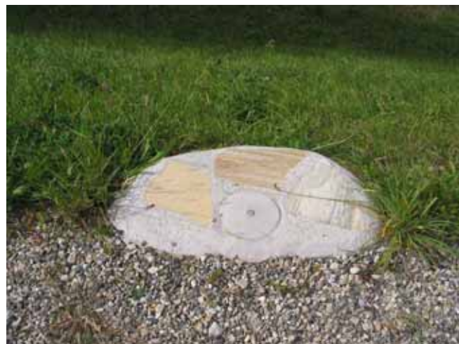
Vermessungsbolzen Dammkrone HRB Laire
