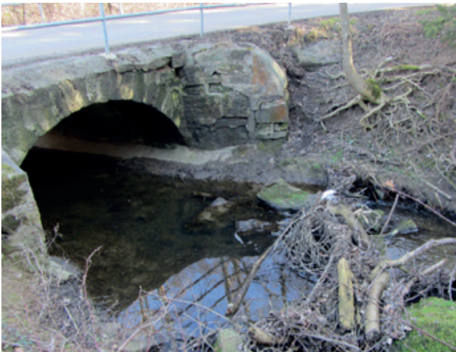
Abb. 3.5: Verklausungen vor einem Durchlass oder umgestürzte Bäume sind durch den Träger der Unterhaltungslast zu entfernen.
