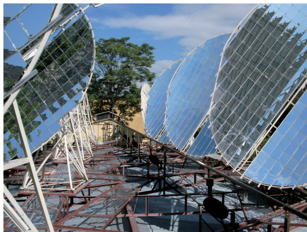
Abb. 17: Energiesammler auf dem Dach des Jamhuriat-Gymnasiums, das mit diesen in Reihe geschalteten Kraftpaketen seine eigene solare Großküche betreibt. Foto: ABS e.V.
