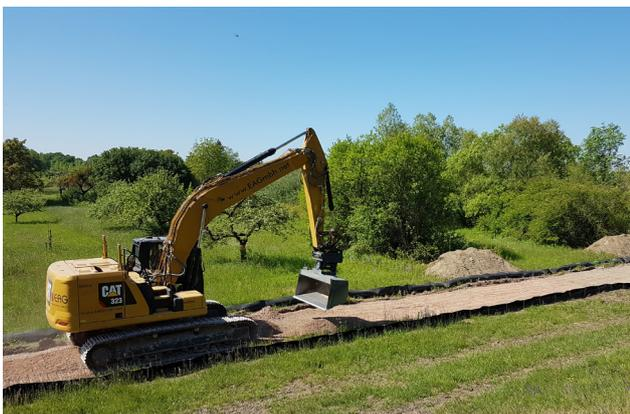
Abbildung 5.1: Anlegen einer Baustraße zur Minimierung von Bodenverdichtungen (© solum)
