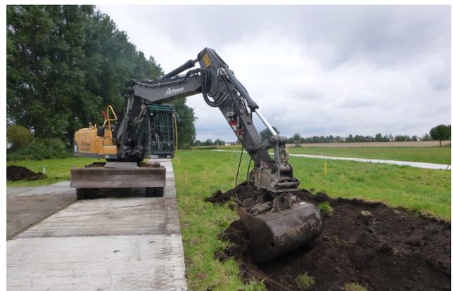
Abbildung 5.2: Baggerarbeiten von Baustraße aus, zur Minimierung von Bodenverdichtungen (© solum)
