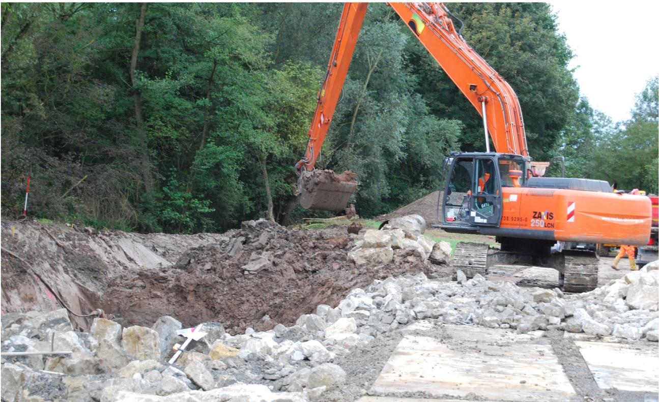
Abbildung 4.2: Erdarbeiten im Zuge einer Gewässerrenaturierung vom Ufer aus mit Langarmbagger auf Druckentlastungsplatten (© N. Billen, terra fusca ing. PartG)
