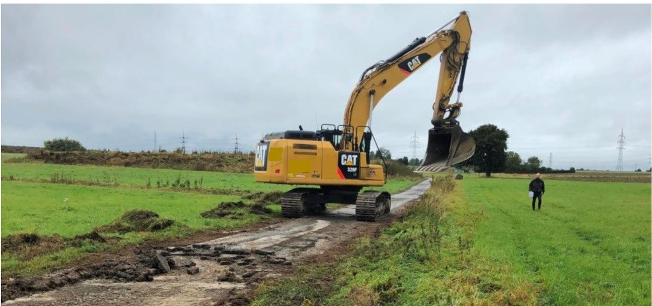
Abbildung 5.3: Beginnender Rückbau eines asphaltierten Feldweges (© Landratsamt Böblingen)
