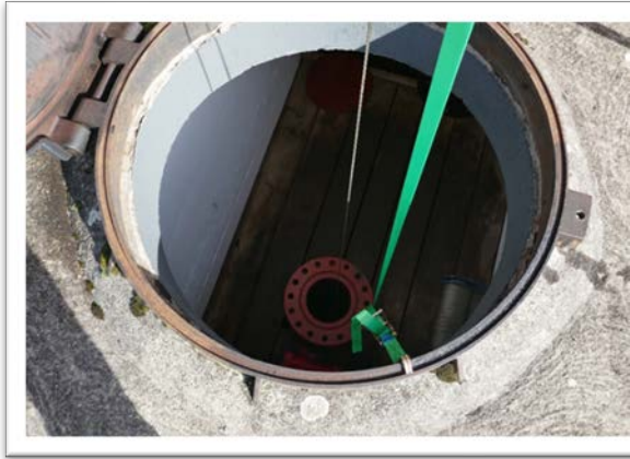
Abb. 8: Bohrlochkopf. Das erste Tool wird in die aufgelassene Tiefbohrung Saulgau GB2 eingefahren.
