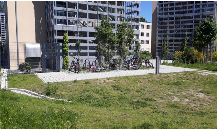
Abbildung 7: Bodengebundene Fassadenbegrünung kombiniert mit dezentralem Regenwasserrückhalt (Foto: Christian Kotremba, LUBW)
