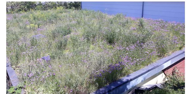
Abbildung 6: Extensivbegrünung eines Flachdachs (Foto: Christian Kotremba, LUBW)
