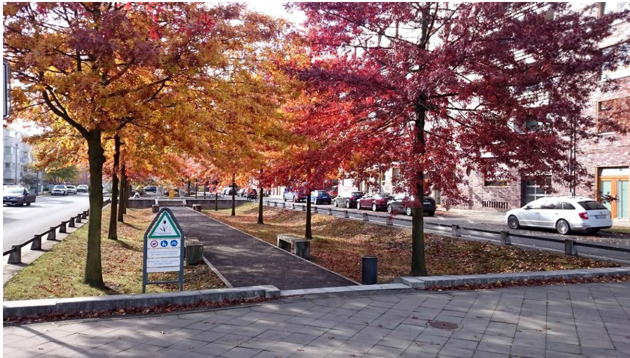
Abbildung 4: Versickerungsmulden zur Straßenentwässerung (Foto: Ingenieurgesellschaft Prof. Dr. Sieker mbH)
