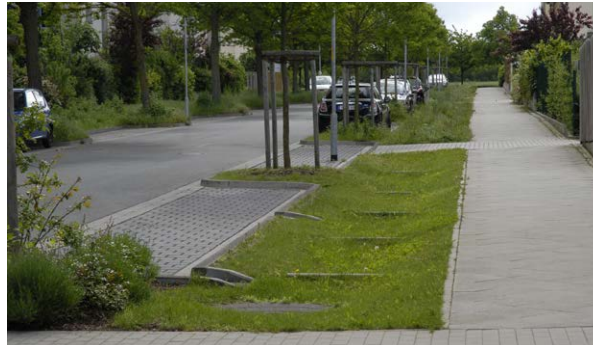
Abbildung 18: Straßenbegleitende Muldenentwässerung (Foto: MUST)
