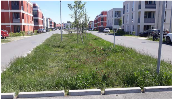
Abbildung 19: Versickerungsmulde im Mittelstreifen (Foto: Christian Kotremba, LUBW)
