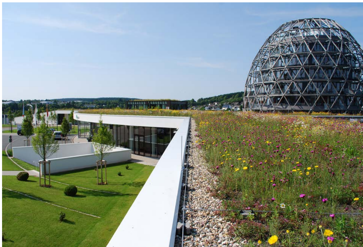
Abbildung 17: extensive Dachbegrünung (Foto: Optigrün international AG)
