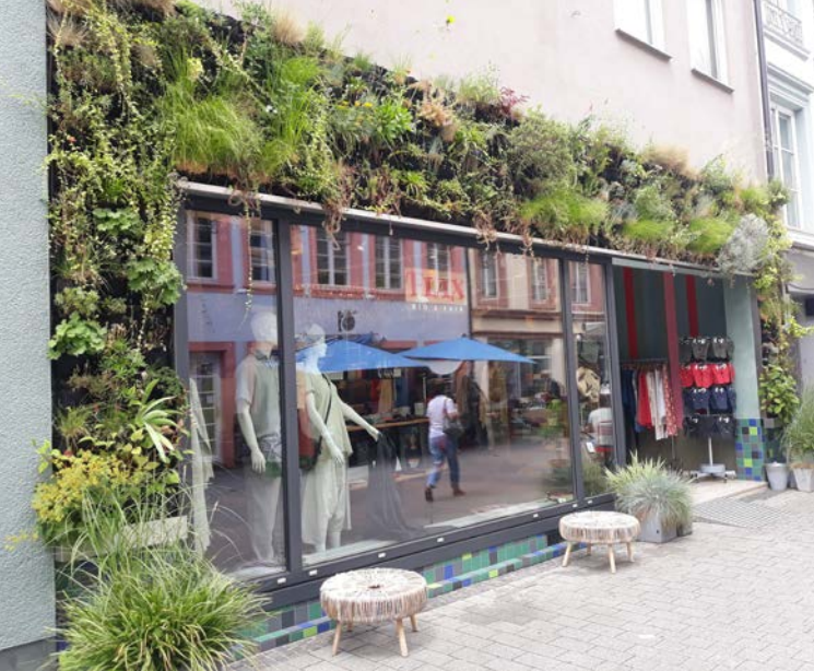
Abbildung 8: Beispiel einer bewässerten, wandgebundenen Fassadenbegrünung (Foto: Christian Kotremba, LUBW)
