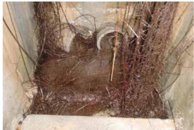
Abb. 3 Messstellen-Überprüfung: Wurzeinwuchs im Quellzulauf
