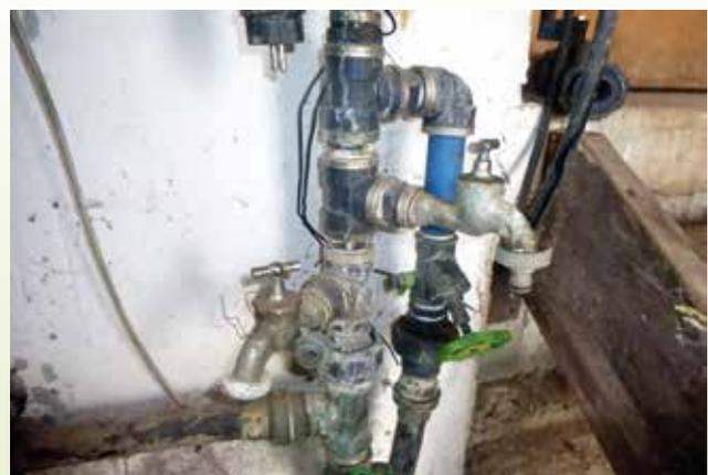
Abb. 4 Messstellen-Überprüfung: Wo kommt das Wasser her? Welcher Hahn ist der richtige?
