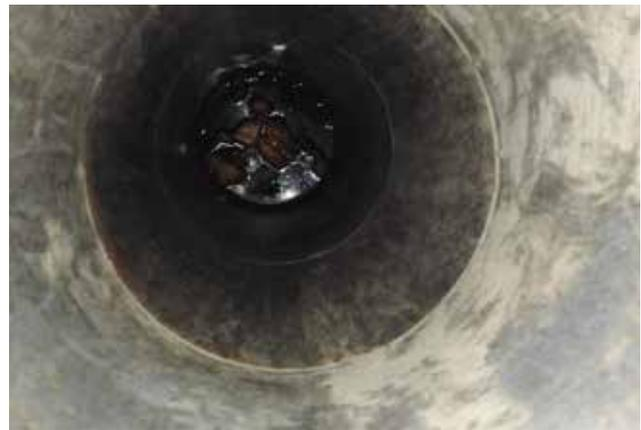
Abb. 1 Messstellen-Überprüfung: Verunreinigungen in einem Brunnen
