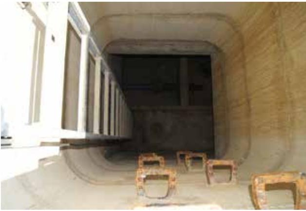
Abb. 5 Messstellen-Überprüfung: Gefährlicher Zugang
