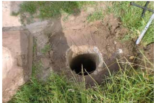
Abb. 2 Messstellen-Überprüfung: Mangelhafte Messstellenabdeckung
