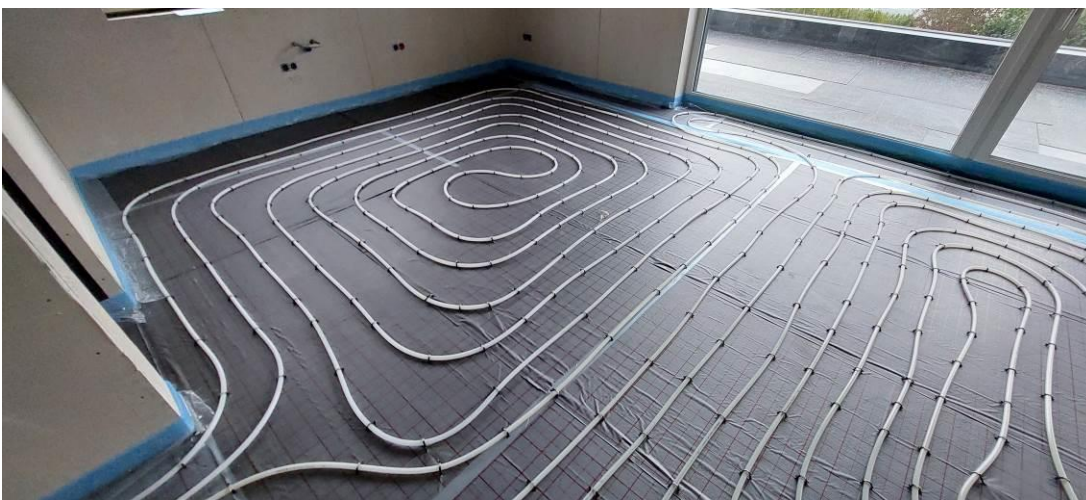
Montage Tackerplatte und Verlegung der Fußbodenheizung
