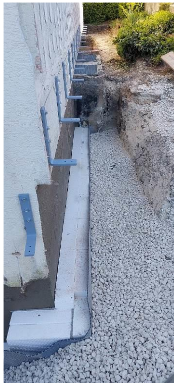
Isolierung und Montage Konsolen - Westseite
