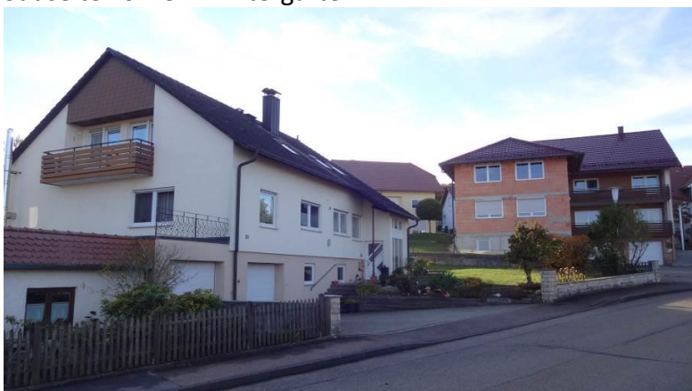
Nord-Ost Seite: Hofeinfahrt und Eingangsbereich / DG mit Balkon
