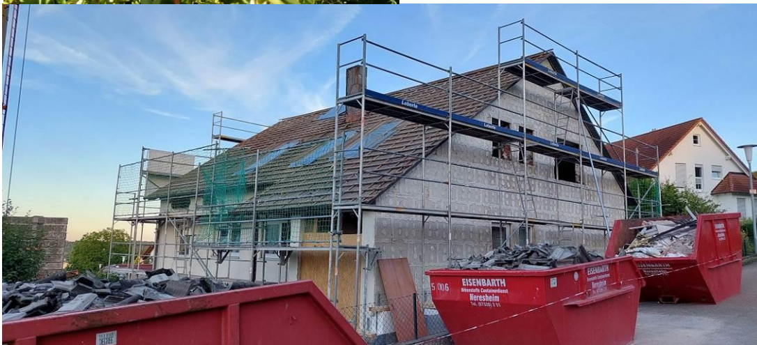
Abdecken des Dachs
