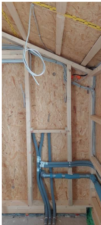
Verlegung Frisch- und Abwasserleitungen
