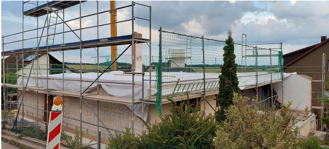
Rückbau Dachstuhl, Giebelwände und Kniestock Dachgeschoss – Süd-/Westseite
