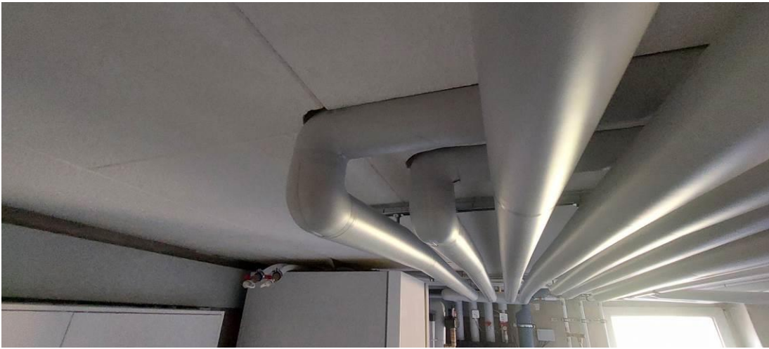
Isolierung der Heizungs- und Warmwasserverrohrung
