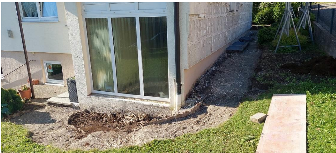
Rückbau Außenanlage – Nord-/Westseite
