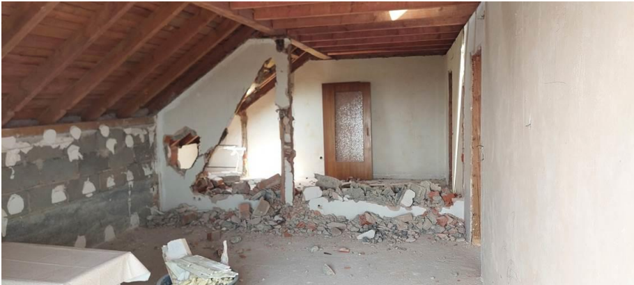
Entnahme Holzdecken, Unterkonstruktion, Gipskartonplatten und Isolierung
