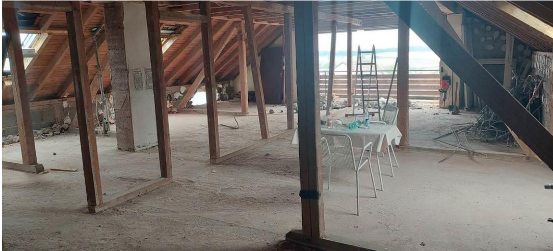
Abbruch- und Rückbau Zwischenwände Dachgeschosswohnung
