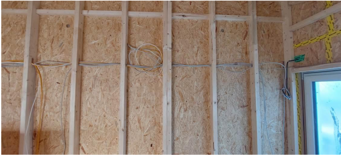
Verlegung Strom, LAN und Koaxialkabel
