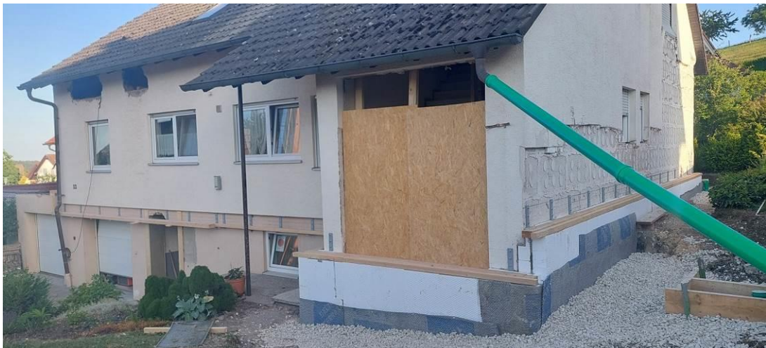
Montage Richtschwellen, Isolierung und Einfüllung der Nord-/Westseite
