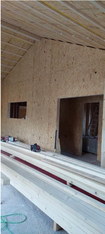
Montage der vorgefertigten Elemente – Dachgeschoss
