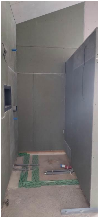
Montage der Gipskartonplatten
