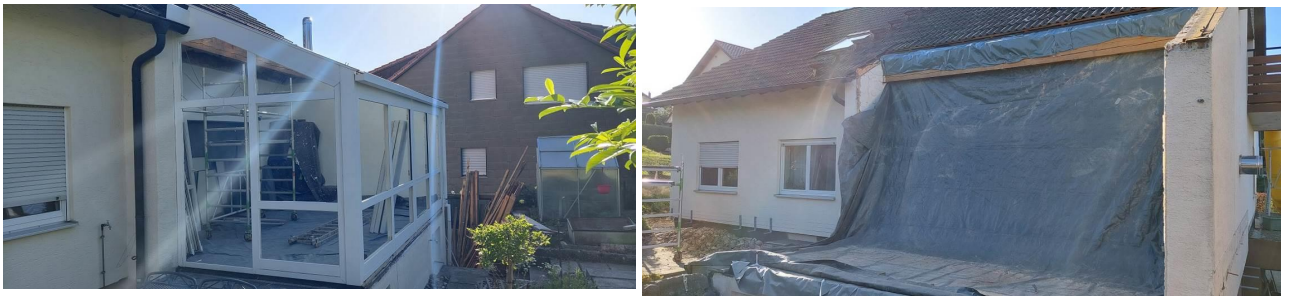
Rückbau Wintergarten – Südseite
