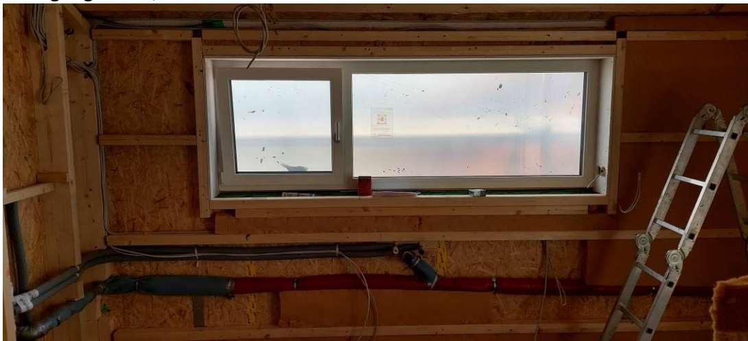
Verlegung Strom, Frisch- und Abwasserleitungen
