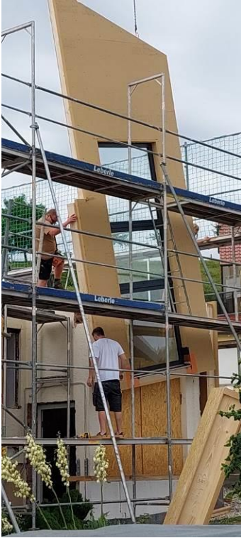
Montage der vorgefertigten Elemente – Erdgeschoss Nordseite
