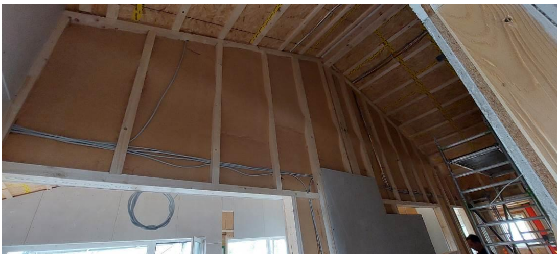
Dämmung der Zwischen- und Außenwände
