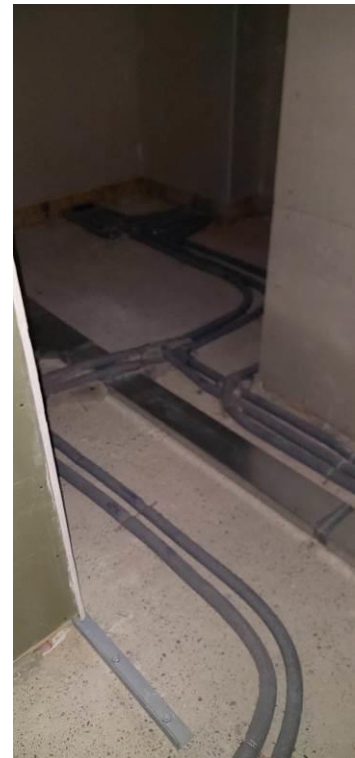
Verlegung Frischwasserleitungen
