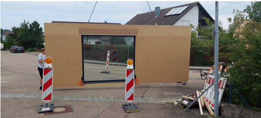
Montage der vorgefertigten Elemente – Erdgeschoss Nordseite
