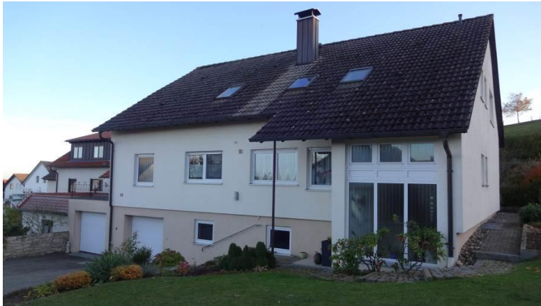
Nord-West Seite vorher: Hofeinfahrt und Eingangsbereich
