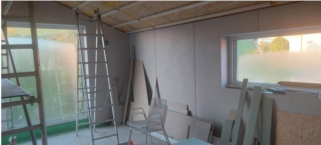
Montage der Gipskartonplatten
