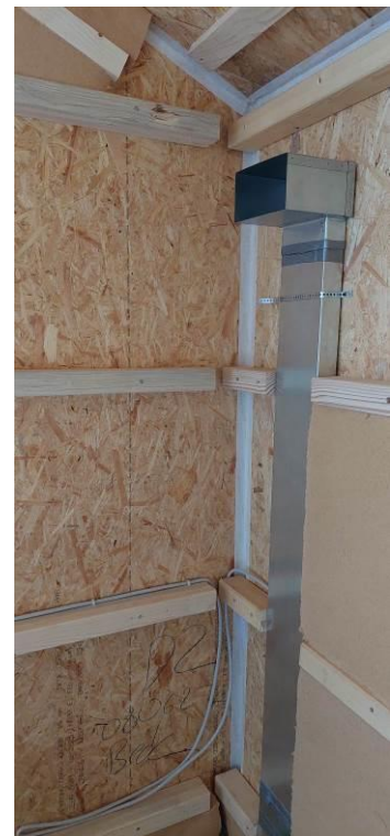
Verlegung Lüftungskanäle
