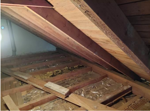
Entnahme Holzdecken, Unterkonstruktion, Gipskartonplatten und Isolierung
