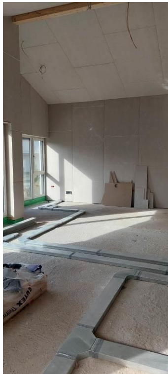
Verlegung Lüftungskanäle
