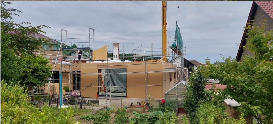
Montage der vorgefertigten Elemente – Erdgeschoss Südseite
