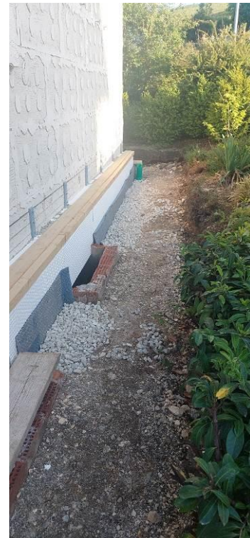
Montage Richtschwellen und Isolierung - Westseite
