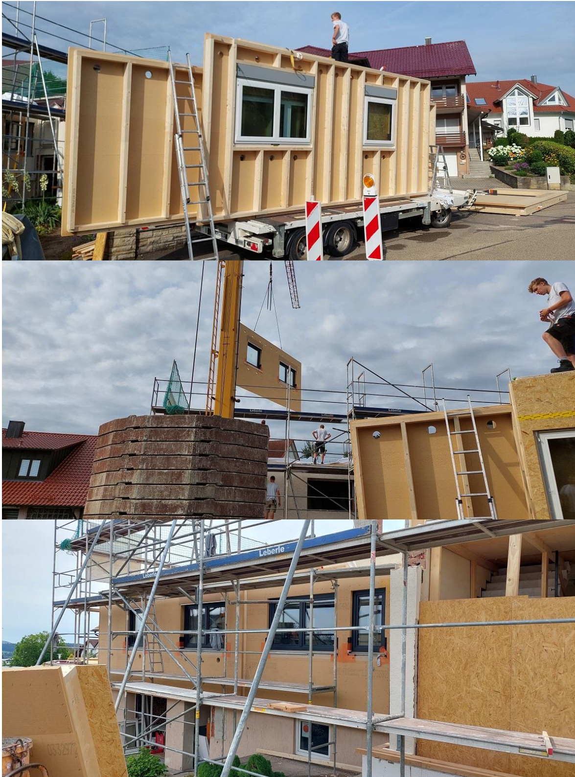
Montage der vorgefertigten Elemente – Erdgeschoss Nordseite
