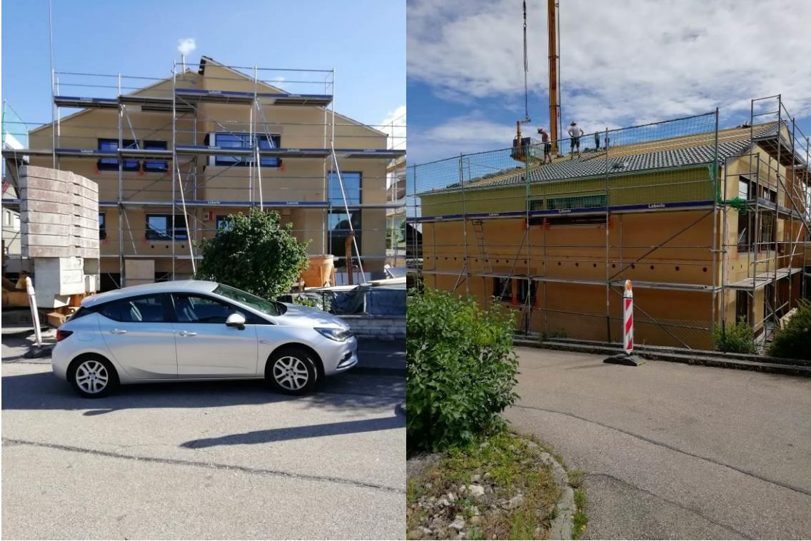
Montage der vorgefertigten Elemente – Dachgeschoss Süd-/Westseite
