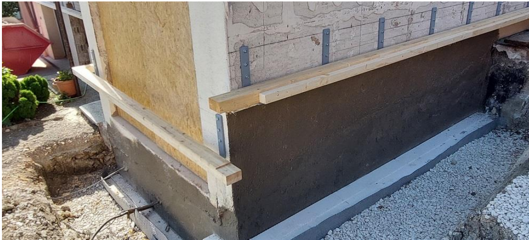
Montage Richtschwellen – Nord-/Westseite
