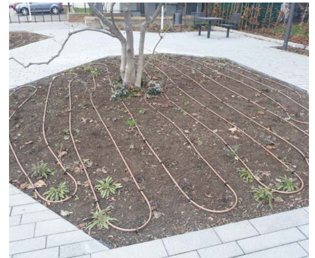
Abbildung 17: Tropfbewässerung einer Grünfläche (Foto: Christian Kotremba, LUBW)
