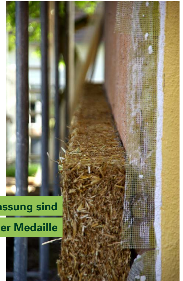
Abbildung 2: Gebäudedämmung mit Strohdämmplatten (Foto: maxit)
