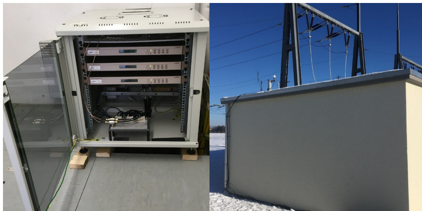
Abbildung 3-2: PMU Monitoring System mit drei Messgeräten für drei vermessene Transformatorabgänge (links). Außeneinheit des Monitoring Systems mit LTE- und GPS-Antennen auf dem Dach eines Relaishauses (rechts).
