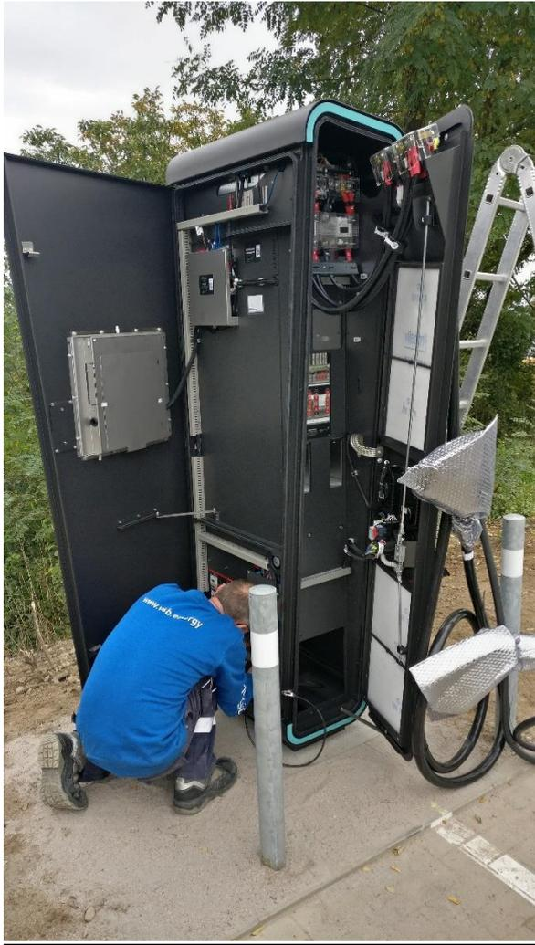
Abbildung 13: Aufbau der DC-Ladesäule
