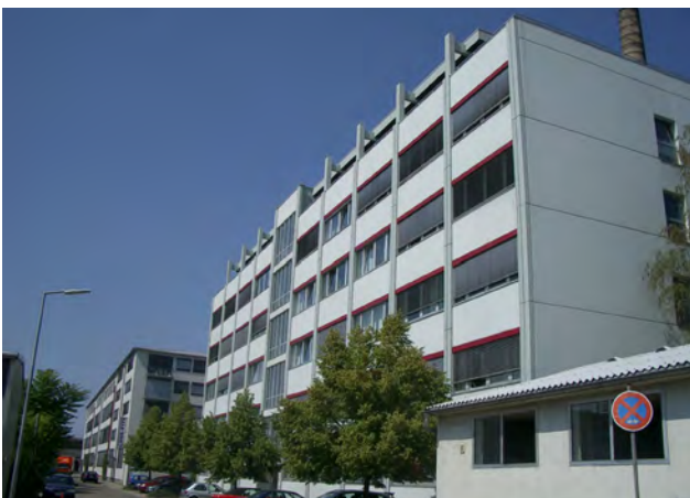
Abbildung 1.2.4: Gebäude Benzstraße 5 Bild: LUBW
