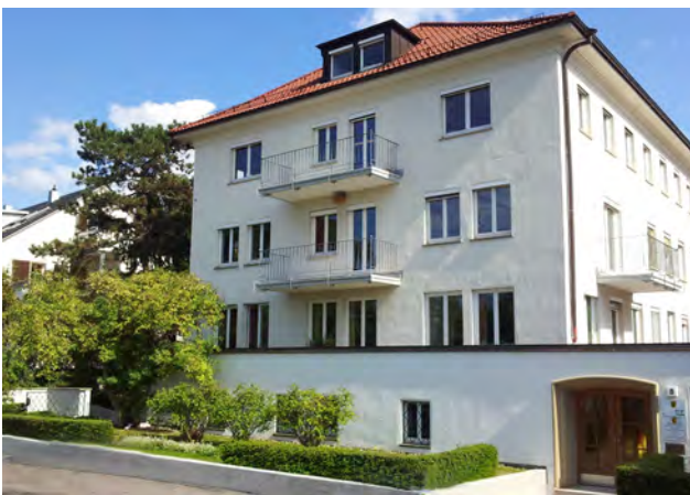
Abbildung 1.2.6: Gebäude Spittlerstraße 8 Bild: LUBW
