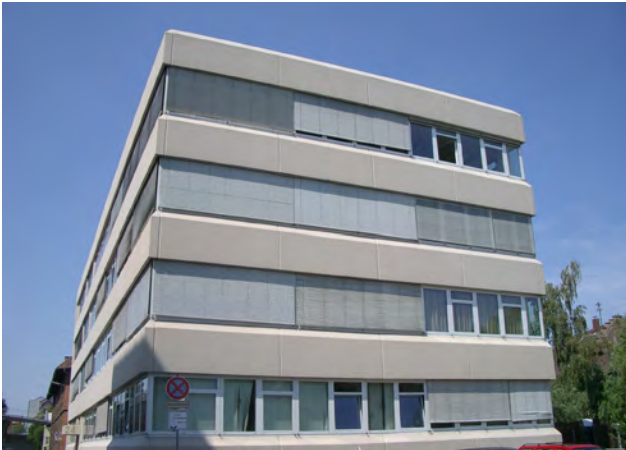
Abbildung 1.2.5: Gebäude Bannwaldallee 24 Bild: LUBW
