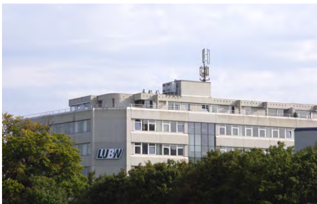
Abbildung 1.2.1: Gebäude Griesbachstraße 1-3 Bild: LUBW
