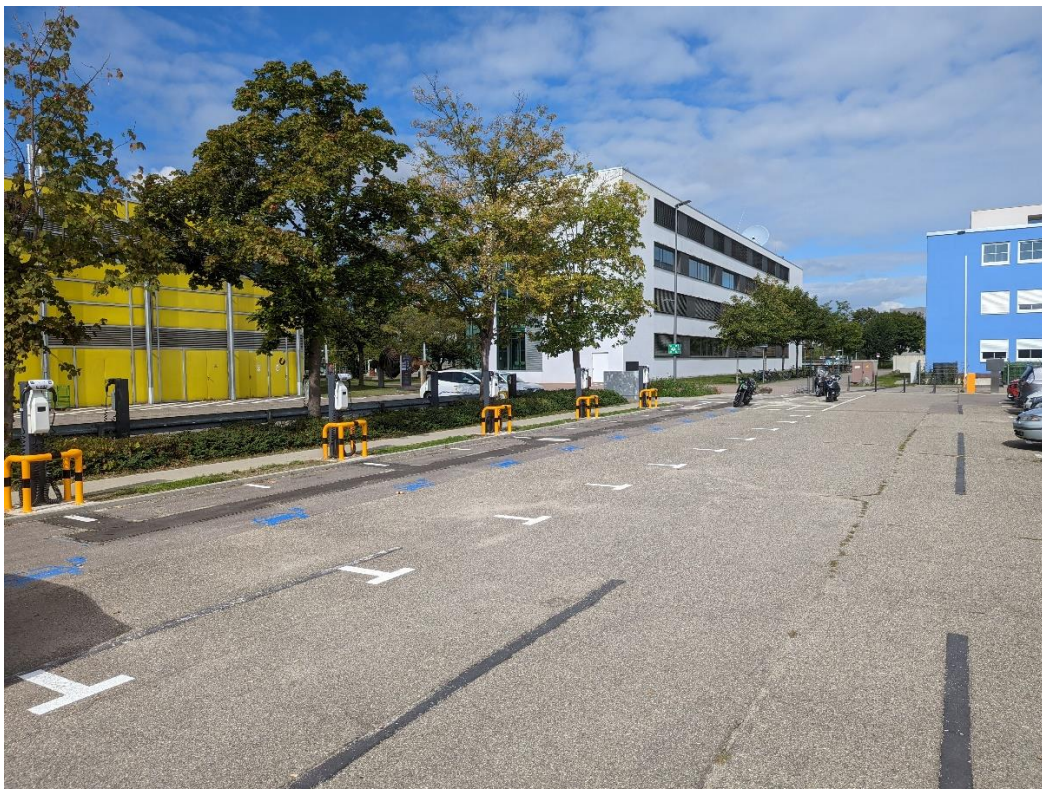
Abbildung 9: Blick auf die Ladeinfrastruktur Westseite – andere Perspektive
