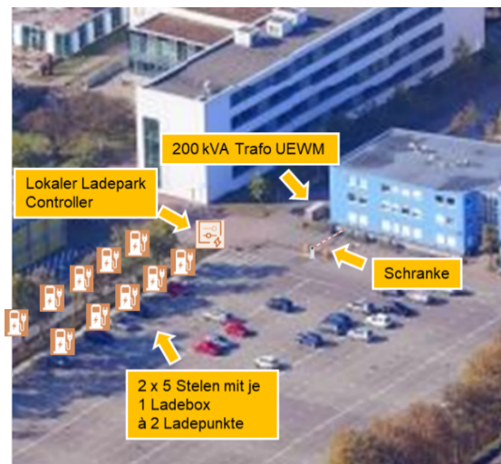
Abbildung 3: Geplanter und realisierter Standort der Ladepunkte (Luftbild im Zoom)
