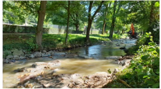
Auflösen bestehender Schwellen am Neumagen [RP Freiburg]
