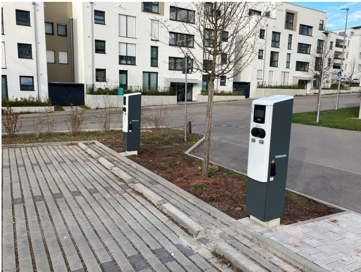
Abbildung 3: Öffentliche LIS Parkplatz (nach Installation)
