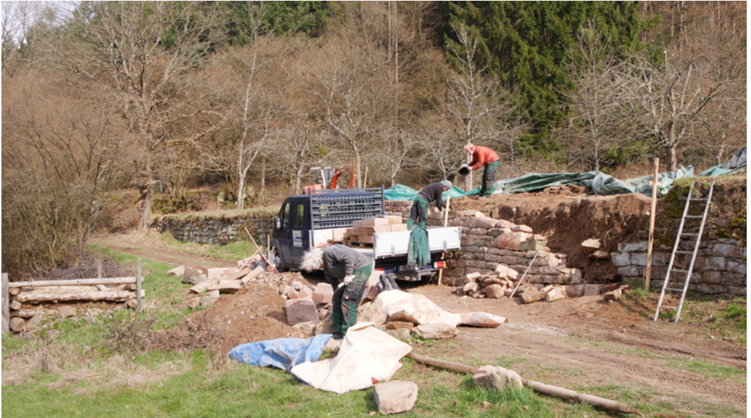
Abbildung 5.10: Restauration einer Trockenmauer im Odenwald. Lebensraum von Äskulapnatter, Schlingnatter und Zauneidechse. Foto: Michael Waitzmann
