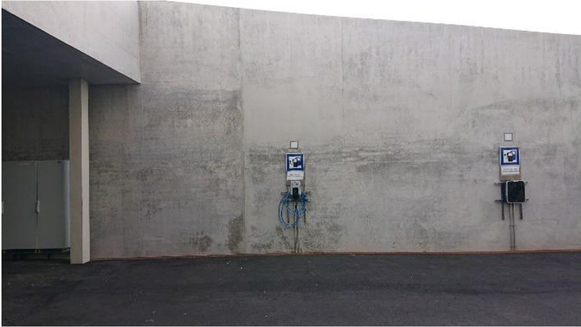
Abbildung 14 Erweiterung des Smart-Grid-Labors um zwei separat ansteuerbare Wallboxen, die jeweils als Ladepark mit zugehöriger Mastereinheit konfiguriert sind
