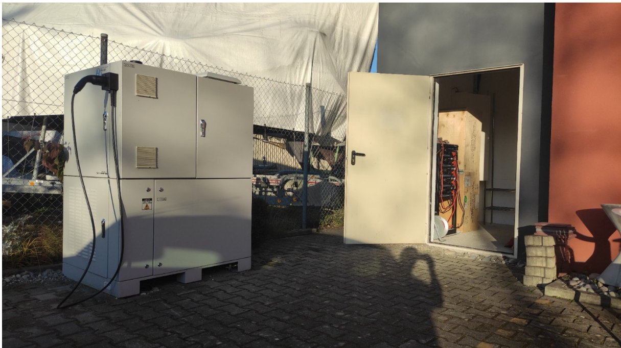
Abbildung 53: Brennstoffzelle mit Batteriespeicher vor dem Gebäude des ISC Konstanz
