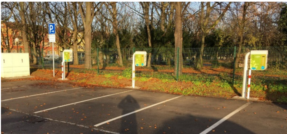
Abbildung 3: Drei doppelte ChargeIT Ladesäulen des Modells: Plug&Play Ladebox. 6 Ladepunkte je 22 kW ( \Sigma max. 33 kW) mit Erweiterungspotenzial
