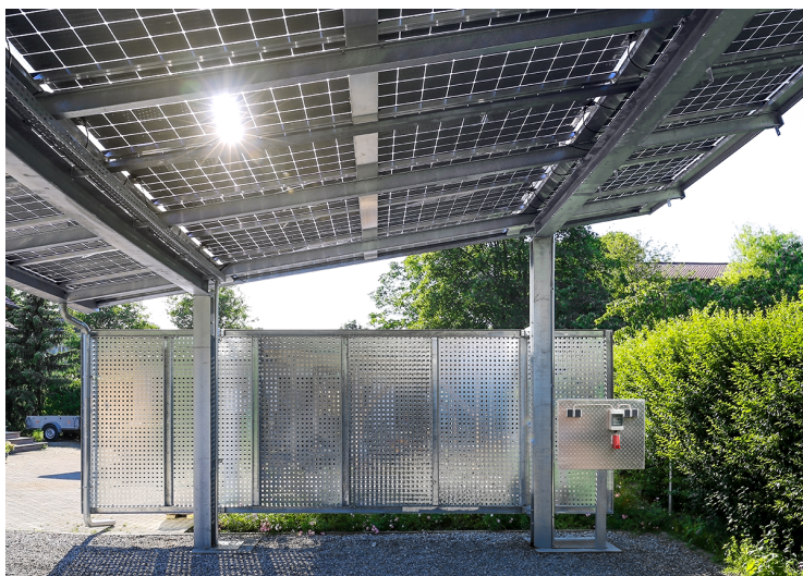
Abbildung 11: Überkopfverglasung eines Solarcarports
