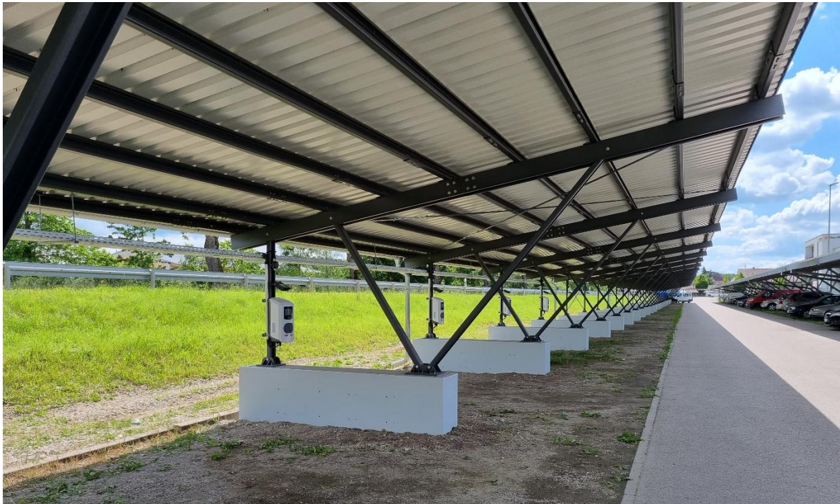
Abbildung 3: Untersicht des neuen Carports nach Fertigstellung
