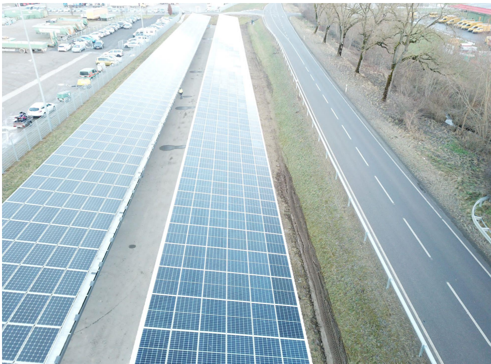
Abbildung 4: Übersicht auf den alten Carport 2013 (links) und neuen Carport 2022 (rechts)
