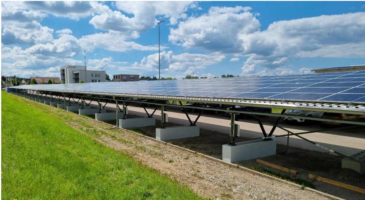
Abbildung 2: Blick von Südosten auf den neuen Solarcarport
