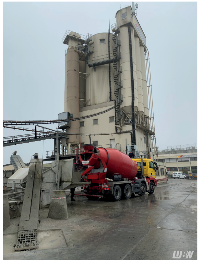
Abb. 1.3: Betonmischer vor Mischturm. Bildnachweis: LUBW
