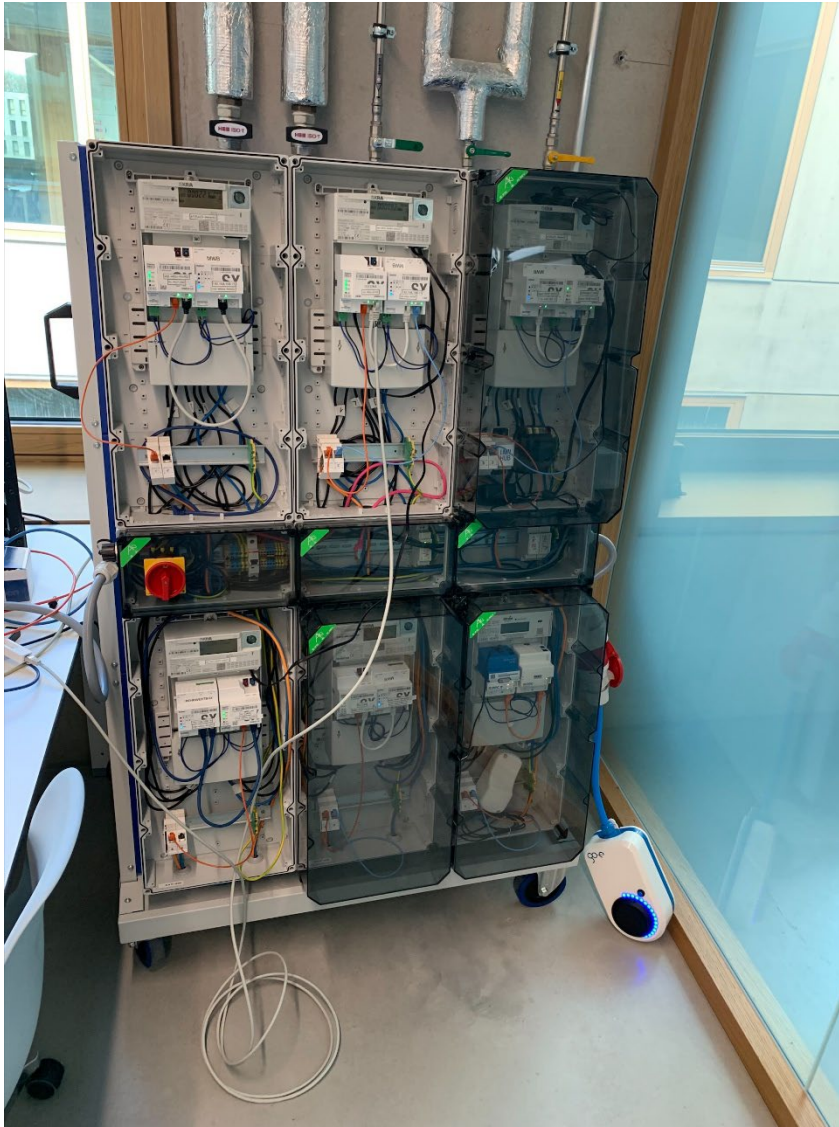
Abbildung 36: Übersicht von den konfigurierten Smart-Meter-Systemen und dem go-E Charger
