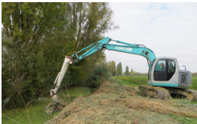
Abbildung 3: Mähkorbeinsatz vom Anliegergrundstück aus [RP Freiburg]
