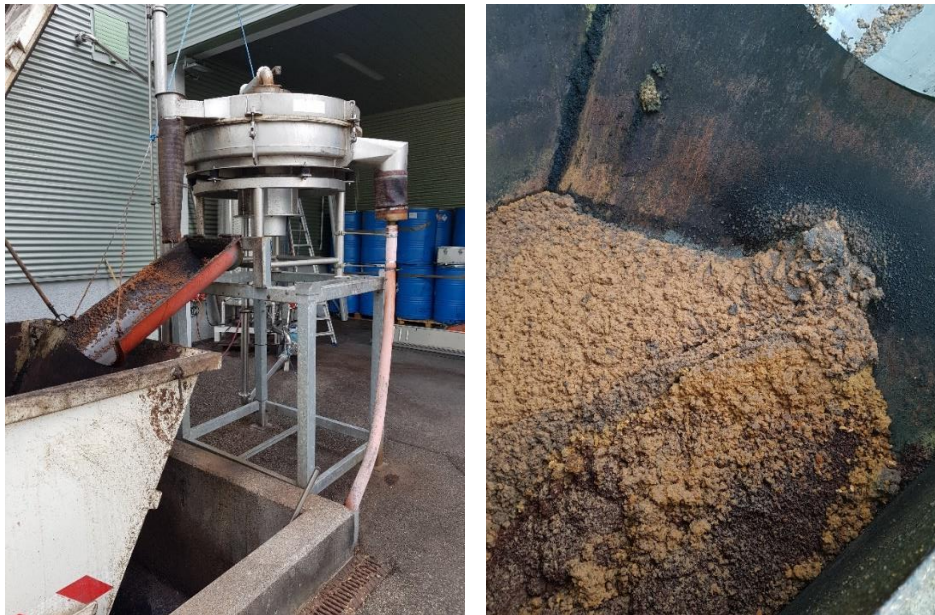
Abbildung 2-23: (a) Entwässerungsanlage (Vibrationsfilter) + (b) Schlempe nach Entfeuchtung [Scharr, 2021]
