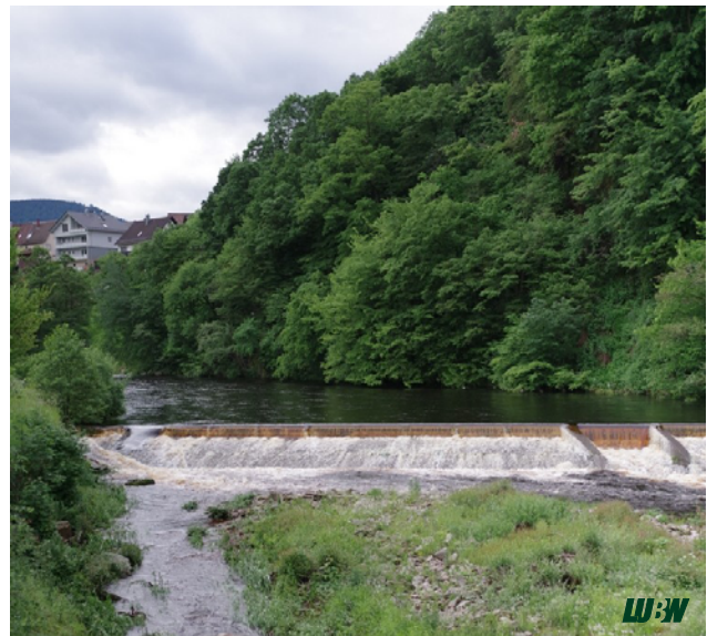
Abbildung 5.2: Fließgewässer mit Rückstau durch ein Querbauwerk.
