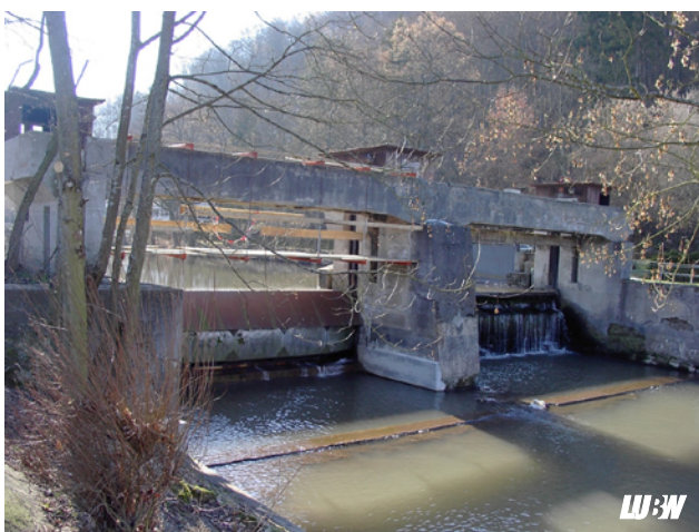
Abbildung 6.3: Foto eines Wehres in der Nähe von Messstelle MS 23 (Nagold, LAWA-Typ 9) als Beleg für den diagnostizierten Rückstau einfluss an der Messstelle. ( http://www2.lubw.baden-wuerttemberg.de/public/abt2/dokablage/10_356/66230/jpg/09458-88430-02-g_47_1300123983.jpg ; Blickrichtung entgegen der Fließrichtung)
