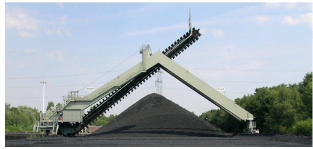
Abbildung 5.7: Halbportalkratzer beim Abkratzen von Kohle an einer Halde. Foto: iMA, 2011.
