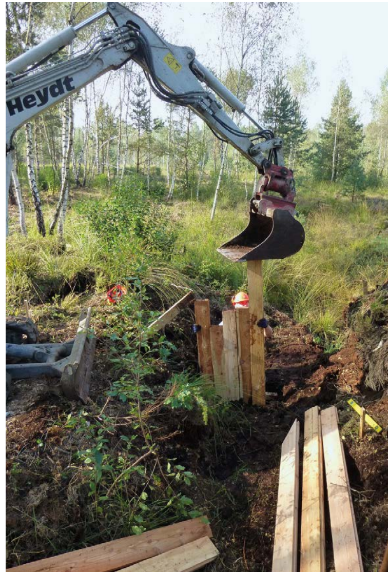
Abbildung 1: Vorarbeiten zur Wiedervernässung im Tannhäuser Ried
