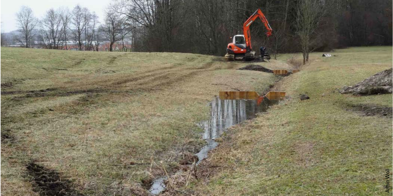
Durch den Einbau von Staubrettern kann das angrenzende Grünland zur Feucht- oder Nasswiese entwickelt werden
