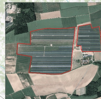
Abb. 2: Beispiel Tauberland-Solarpark bei Dörlesberg, EEG Schlüssel: E10843010000000000000051009000001 40.951 MW/h Nennleistung, 2012 eingespeiste Leistung: 46.938,45 MWh; Ca. 728.000 m² Fläche.
