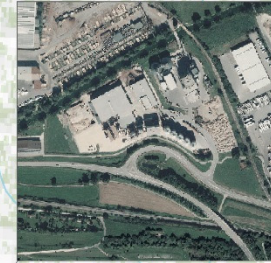
Abb. 2: Beispiel Biomasse-Heizkraftwerk Herbrechtingen, Nennleistung: 15.700 kW; EEG Schlüssel: E1084301000ZE000000530927VS000001 2012 eingespeiste Leistung: 92290,66 MWh, seit 2004 in Betrieb
